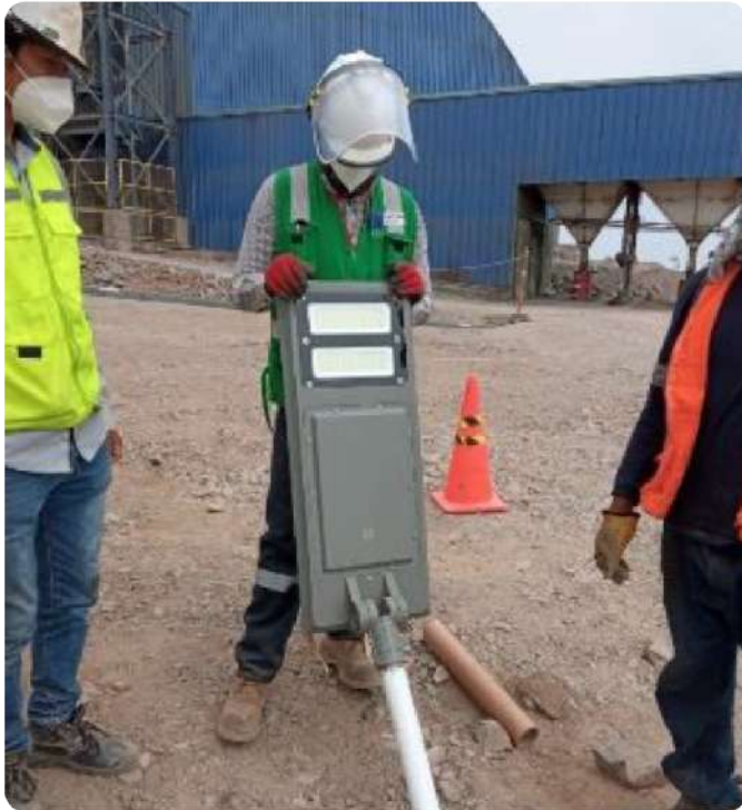
Postes de luz con paneles solares
