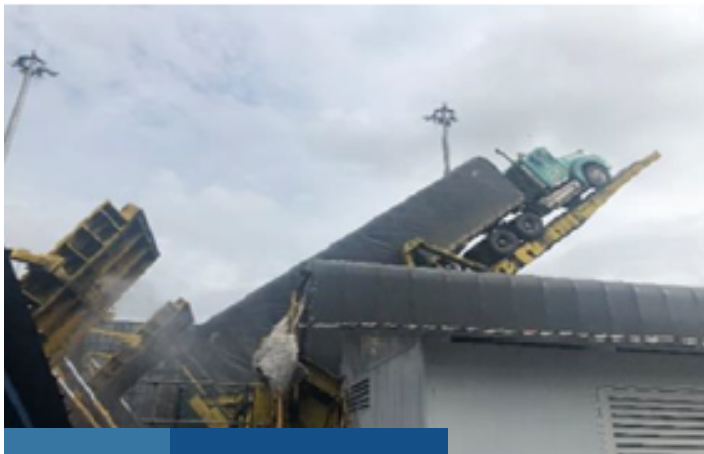
Volcadores con sistema de rociado de aguas lluvias.
