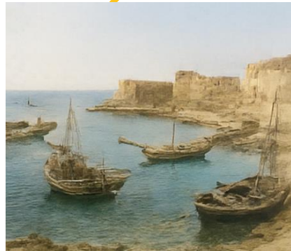
1ª generación Puertos antiguos. Interfaz tierra-mar.
